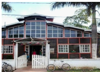
Foto 3: Fachada da escola
