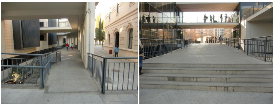
Foto 10 y 11. Escalera ancha y rampa del aula
