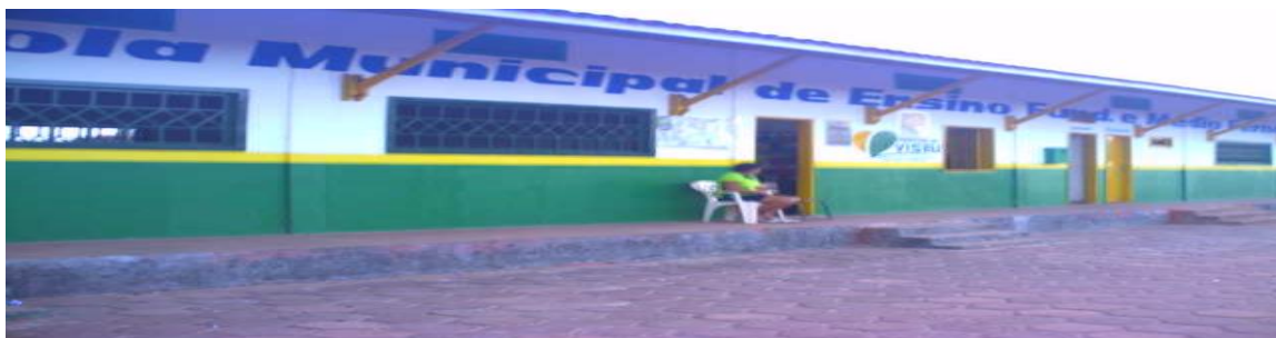
Figura 01: Escola Municipal de Ensino Fundamental Fernandes Belo.
